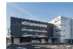
エンジニアリング事業本部 新社屋完成 (2018年)
