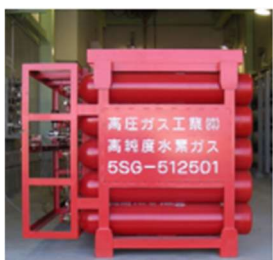
水素カードル
