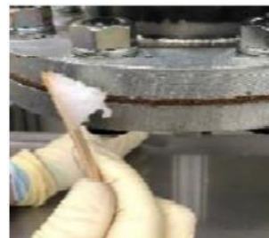
②漏油箇所に塗布
