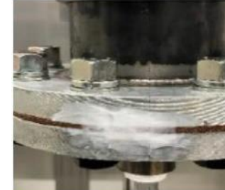
④漏油の簡易リペア完了
